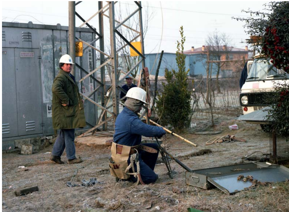
LAVORI DI RIPRISTINO DI LINEE MT
