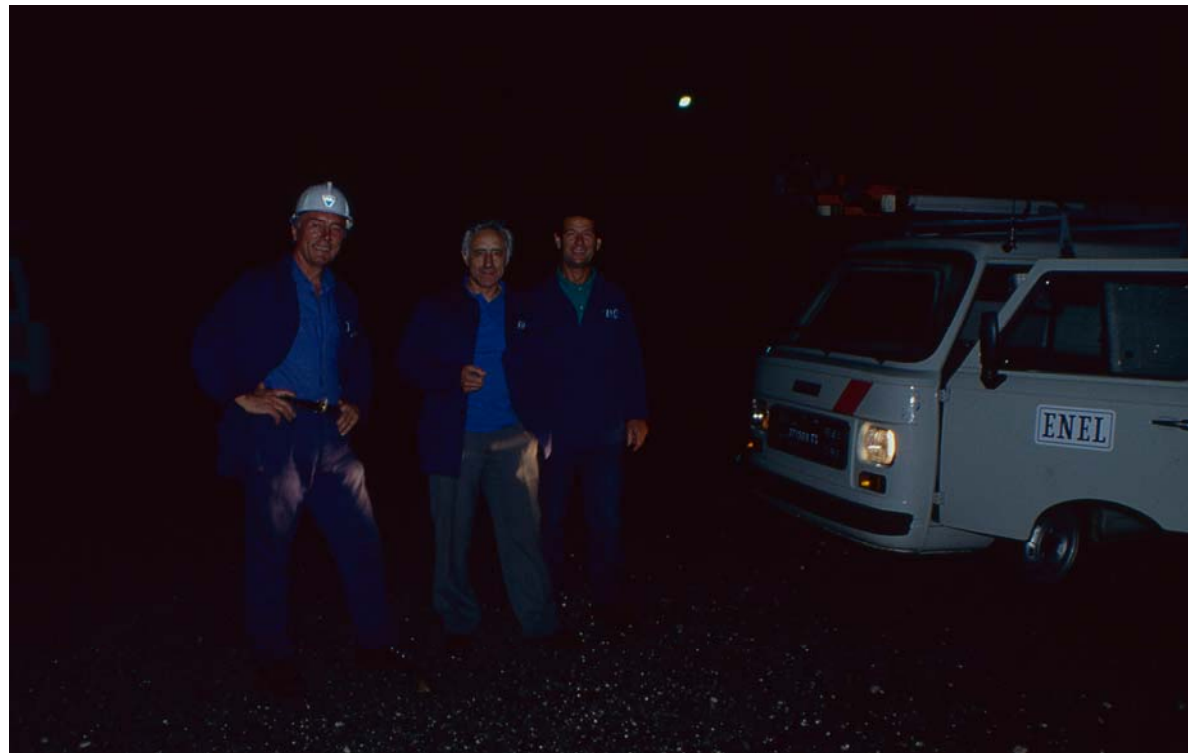
LAVORI DI RIPRISTINO NOTTURNO DI LINEE MT
