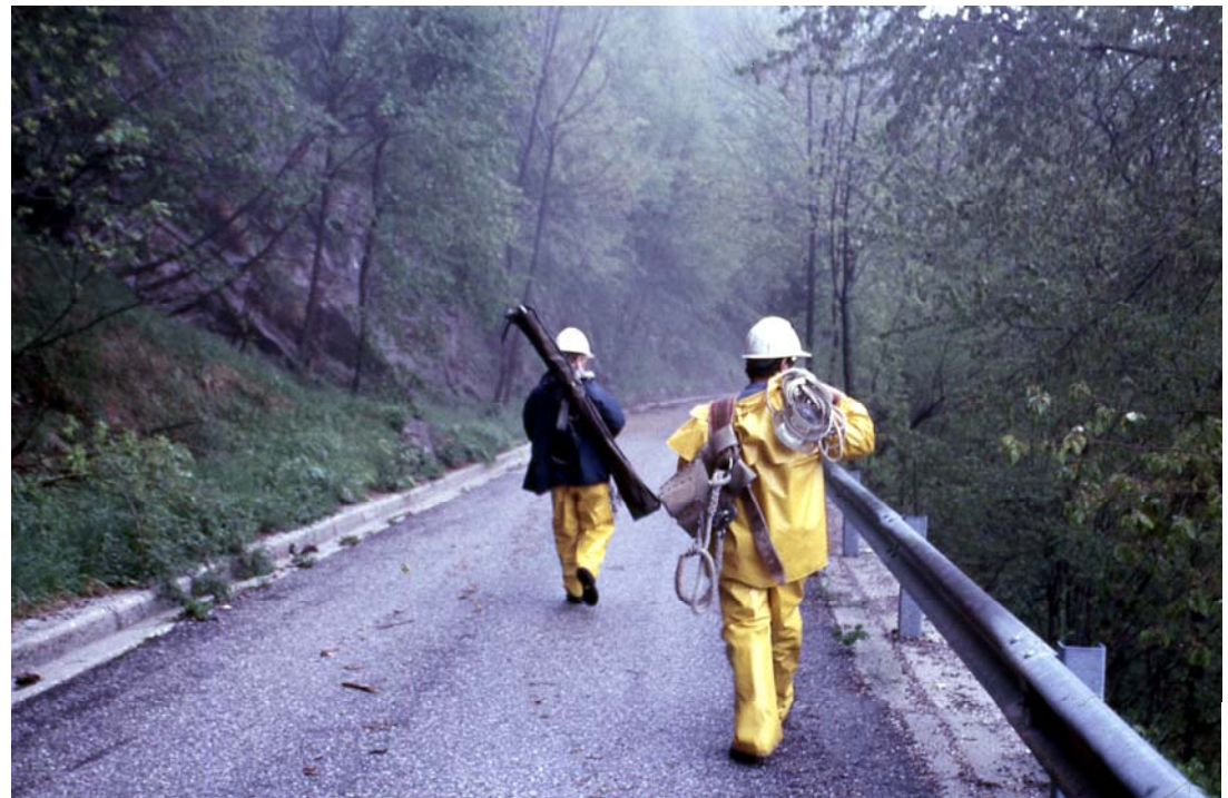
LAVORI DI RIPRISTINO NELLA PIOGGIA
